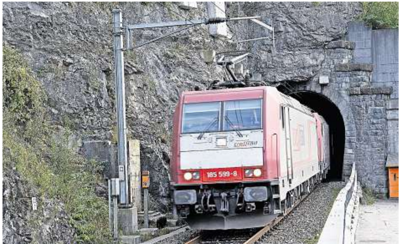
Für den künftigen Nord-Süd-Güterverkehr sowie die doppelstöckigen Personenzüge müssen die seeseitigen Axentunnels saniert und auf vier Meter Höhe ausgebaut werden.
